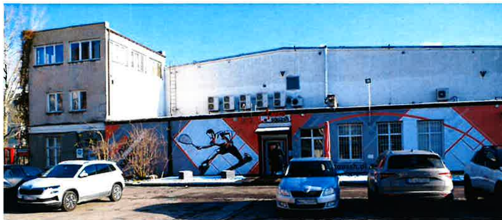
Widok od strony północnej
